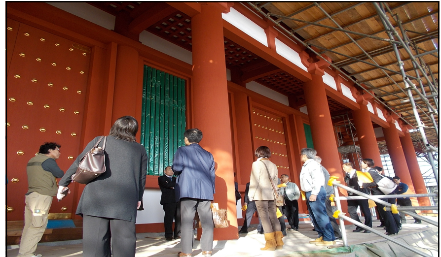
興福寺中金堂 再現現場
