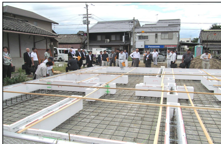
基礎断熱施工現場の見学の様子
